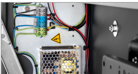
fachgerechte Verkabelung und Absicherung nach VDE (E-Check)
