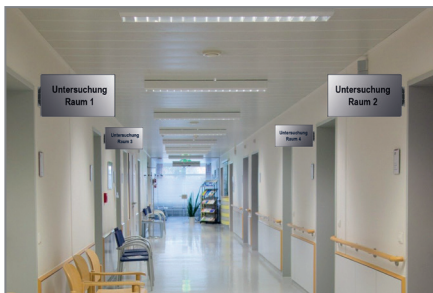
Installation von der Wand in den Raum
